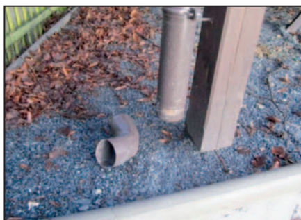
Foto zachycují polodetailní a detailní pohled na poškozené okapní svody a na podbití zastřešeného prostoru na sportovním areálu TJ SOKOL BOUZOV. K tomuto poškození došlo v přímé souvislosti s odpalováním zábavní pyrotechniky)
