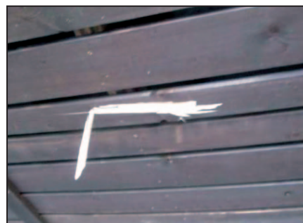
Foto zachycují polodetailní a detailní pohled na poškozené okapní svody a na podbití zastřešeného prostoru na sportovním areálu TJ SOKOL BOUZOV. K tomuto poškození došlo v přímé souvislosti s odpalováním zábavní pyrotechniky)
